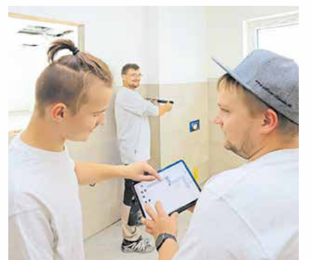
Mit einer speziellen App können Fliesenlegermeister Lukas Pittner (rechts) und seine Mitarbeiter Maximilian Tüchert und Sebastian Krüger nicht nur den Materialeinsatz auf der Baustelle besser planen. Durch die EDV-Schnittstelle konnte auch der Zeitaufwand für die Dokumentation deutlich reduziert werden. Foto: Rudi Merkl
